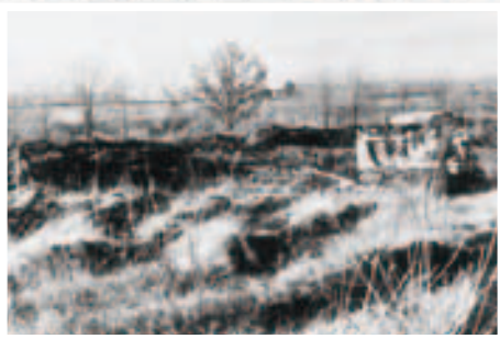
開園前の整地作業
